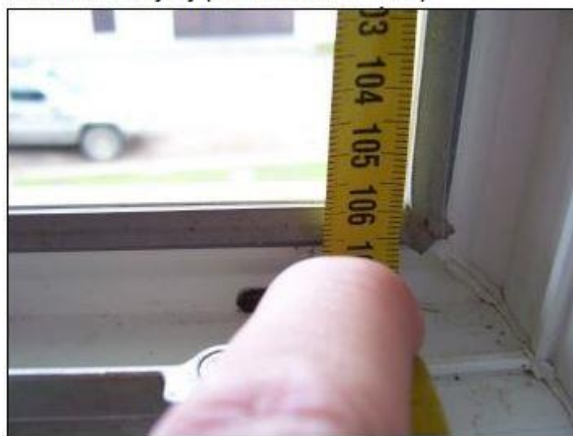
2 - zaměření výšky ( měřte na 3 místech )
