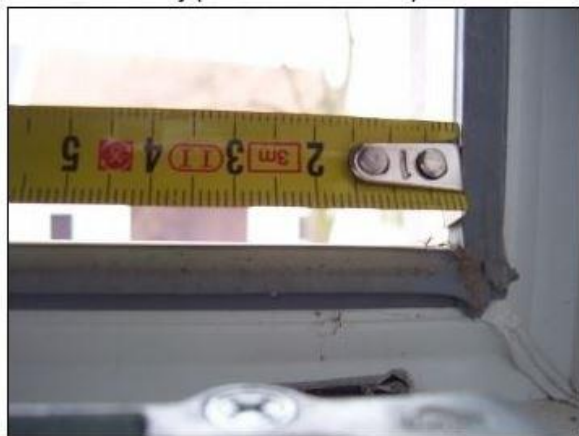
1 - zaměření šířky ( měřte na 3 místech )
